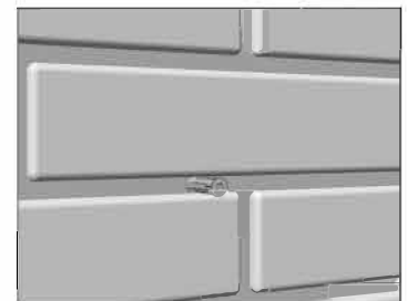
Dübel in die Bohrlöcher einsetzen.
